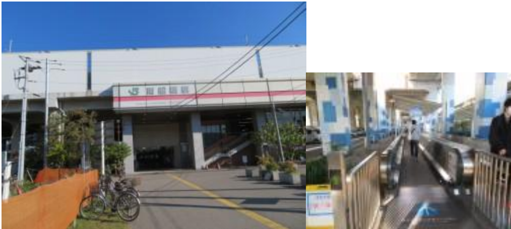
※南船橋駅、動く歩道
