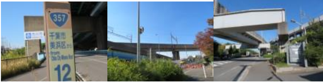
※市川市へ（千葉市から 12 km地点）、二俣支線登場、二俣支線と高谷支線の合流点
